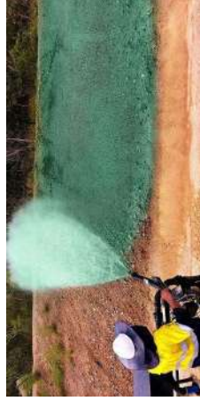
Mise en œuvre d'un hydromulching
