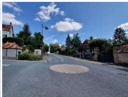
Aménagement routier n'incitant pas au ralentissement
